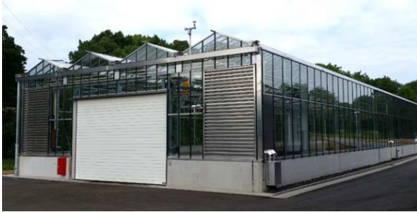
Abbildung 14: Solar- und Bandtrockner (Quelle: Thermo-System, Huber SE)
